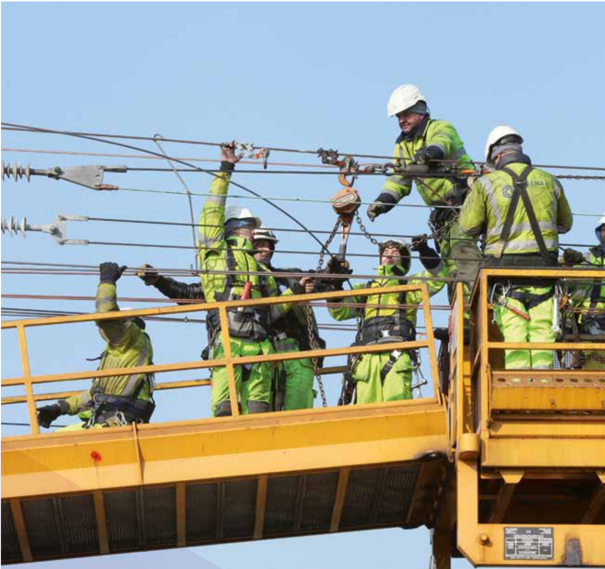
↑ Aanpassingswerken bovenleiding Brugge
