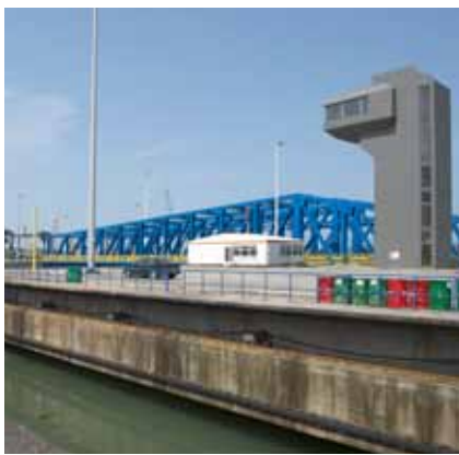
Infra Automation at Lock Pierre Vandamme (Zeebrugge)
