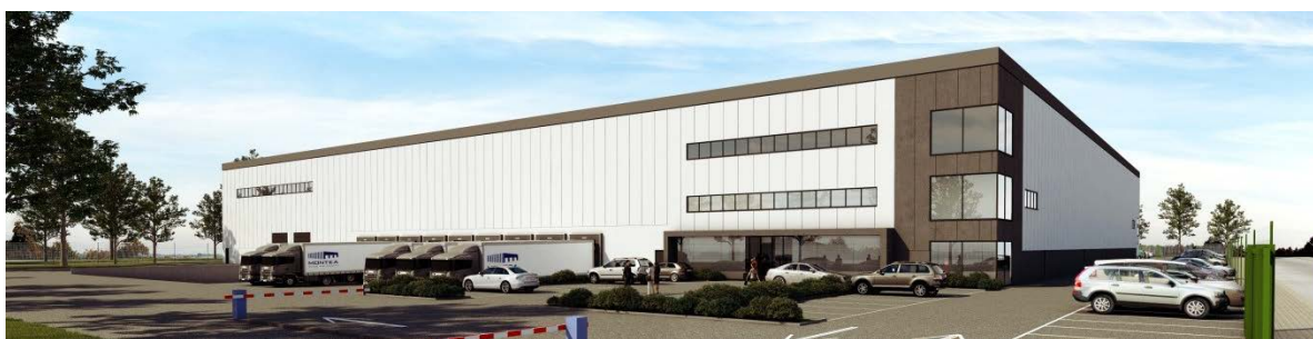
Montea «Space for Growth» - Nieuw luchtvrachtgebouw voor SACO Groupair - Brucargo (BE)
