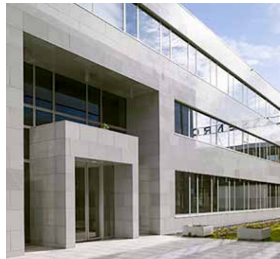
Kantoorgebouw West End - Groot-Bijgaarden (BE)
