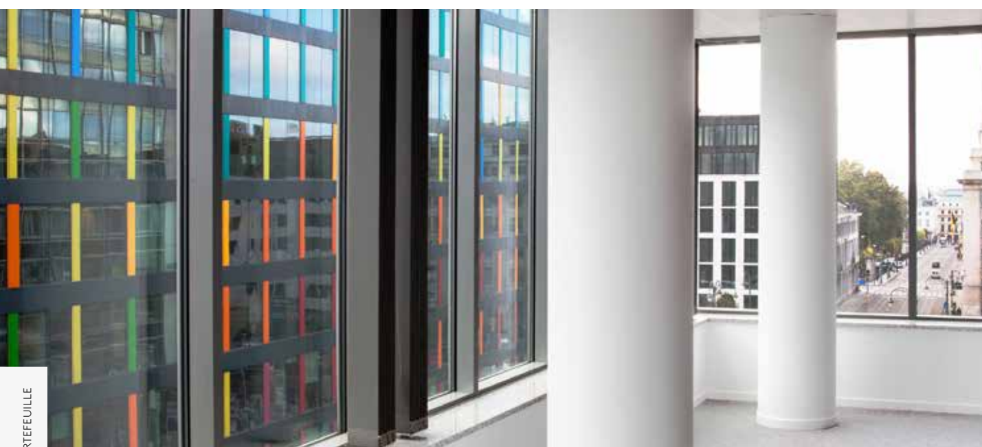
Kantoorgebouw Wet 34 - Brussel (BE)
