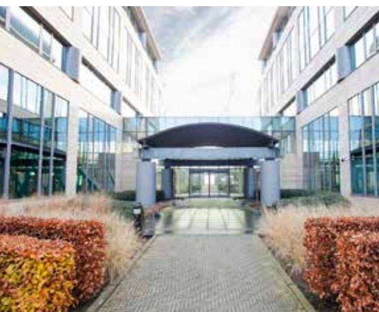
Kantoorgebouw Park Lane C - Diegem (BE)
