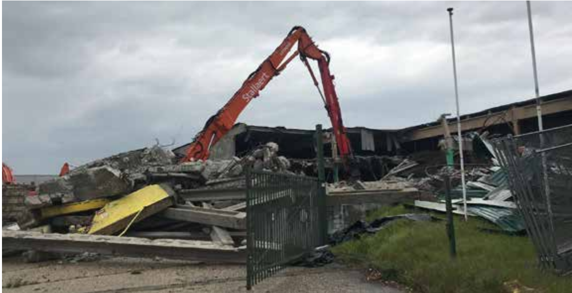
De site in Zellik: afbraak van de bestaande gebouwen
