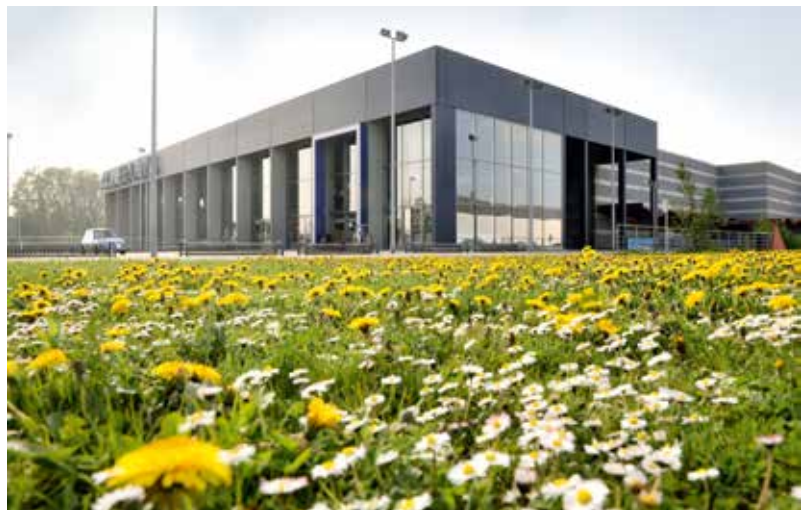
Bij renovaties van bestaande complexen worden energiebesparende maatregelen genomen.
