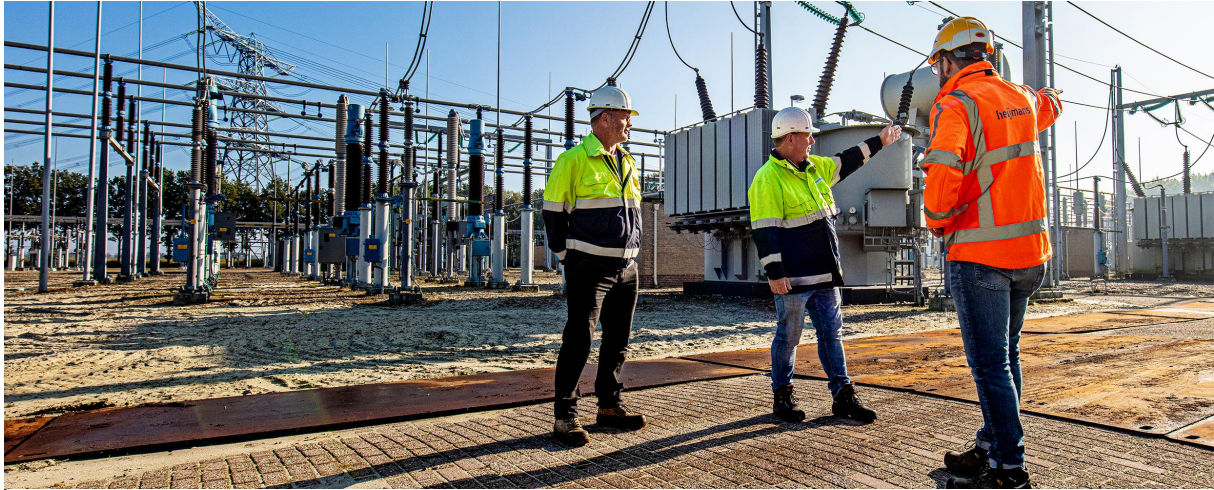
Ingo Seuren van Heijmans, Douwe Zijlstra en bouwleider Hans Greven van TenneT op het hoogspanningsstation in Meeden.
