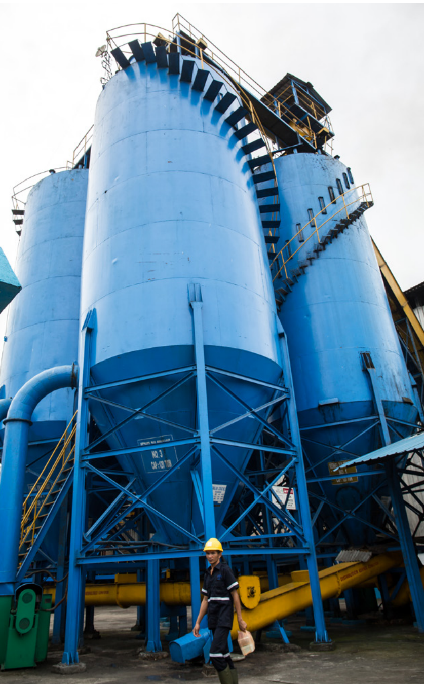
Silo's voor bulkopslag van palmpitten
