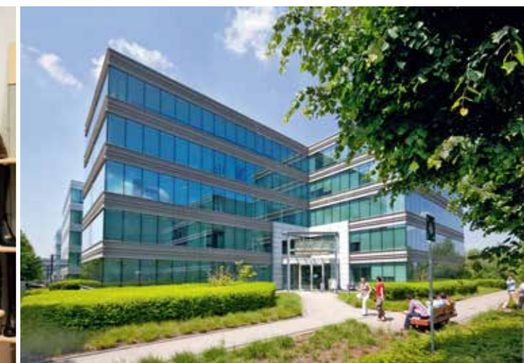
Office building Medialaan, Vilvoorde
