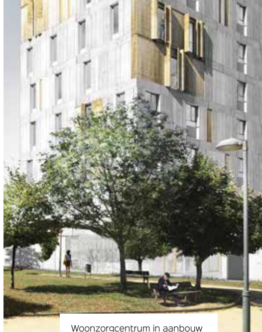
Woonzorgcentrum in aanbouw - Vigo (ES)
