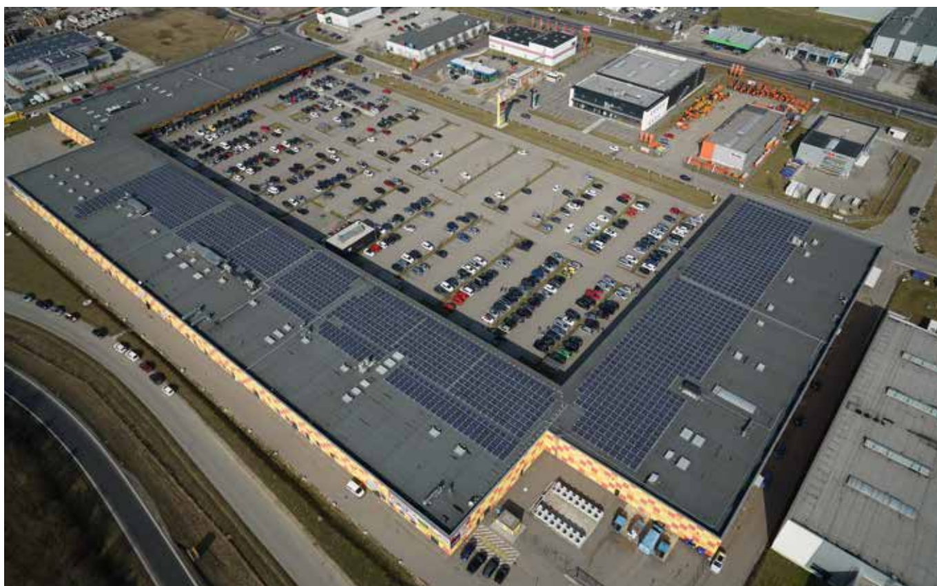
Leasinvest Real Estate - Zonnepanelen op het dak van het Frun® retailpark - Asten - Oostenrijk
