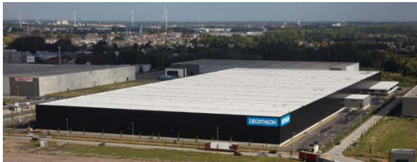
Montea «Space for Growth» - Site Willebroek MG Park De Hulst - Decathlon (BE)
