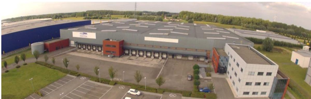
Montea «Space for Growth» - Site Puurs Schoonmansveld 28
