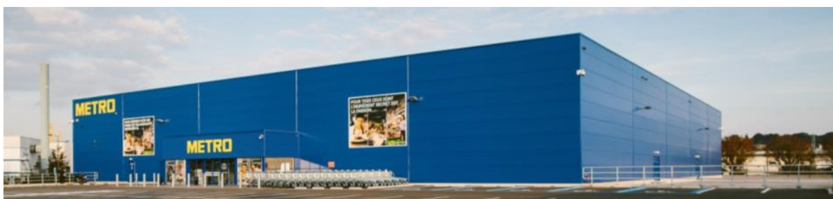
Montea «Space for Growth» - site Vorst - Metro (BE)
