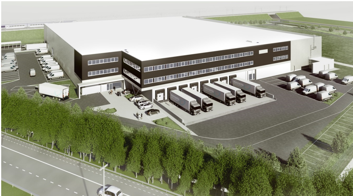
Montea «Space for Growth» - Site Zuid IV Erembodegem - Movianto (BE)
