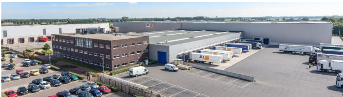
Montea «Space for Growth» - site 's-Heerenberg (NL)
