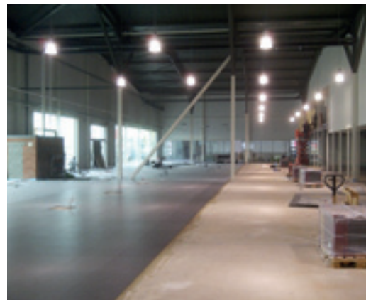
12. plaatsing vloertegels in showroom - afwerking kantoren
