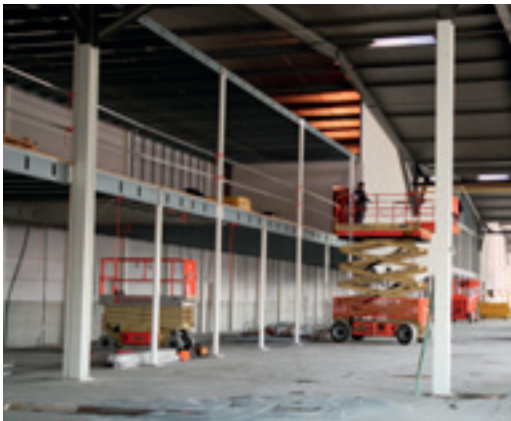
9. constructie draagstructuur nieuwe kantoren
