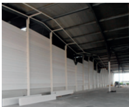
4. constructie brandoverslagbeveiliging
