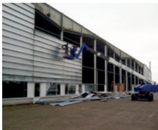
2. afbraak bestaande gevelbekleding
