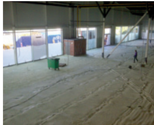
10. spuiten vloerisolatie in showroom
