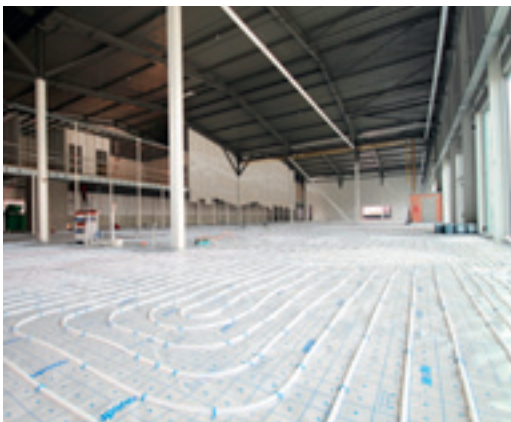
11. plaatsing vloerverwarming in showroom
