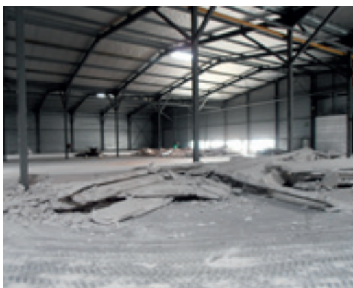
1. afbraak bestaande brandmuren en wanden
