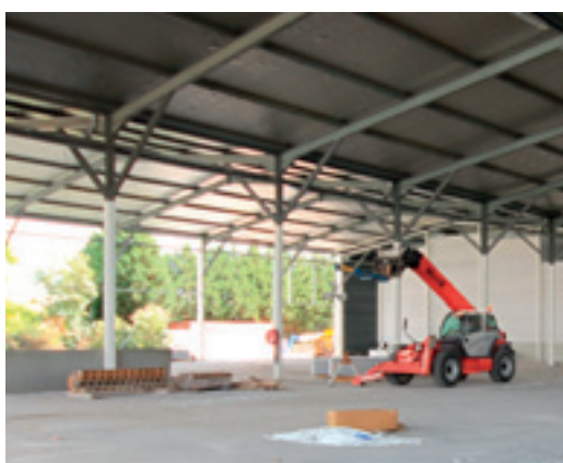
3. installatie brandmuur achterliggende oppervlakte
