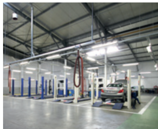
16. bruggen in werkplaats geplaatst
