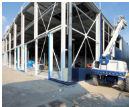
6. plaatsing sandwichpanelen nieuwe gevel
