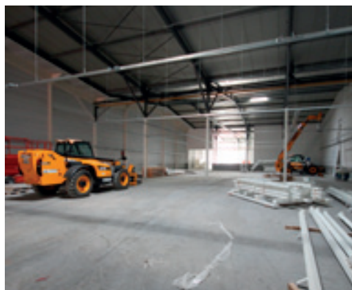
8. realisatie brandmuur tussen showroom en werkplaats
