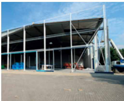
5. realisatie draagstructuur nieuwe gevelbekleding
