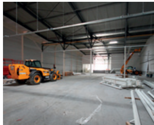
14. installatie kabelgoten voor elektriciteit in werkplaats
