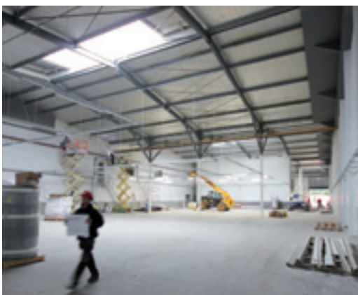
15. installeren verlichting en luchtextractiesysteem in werkplaats
