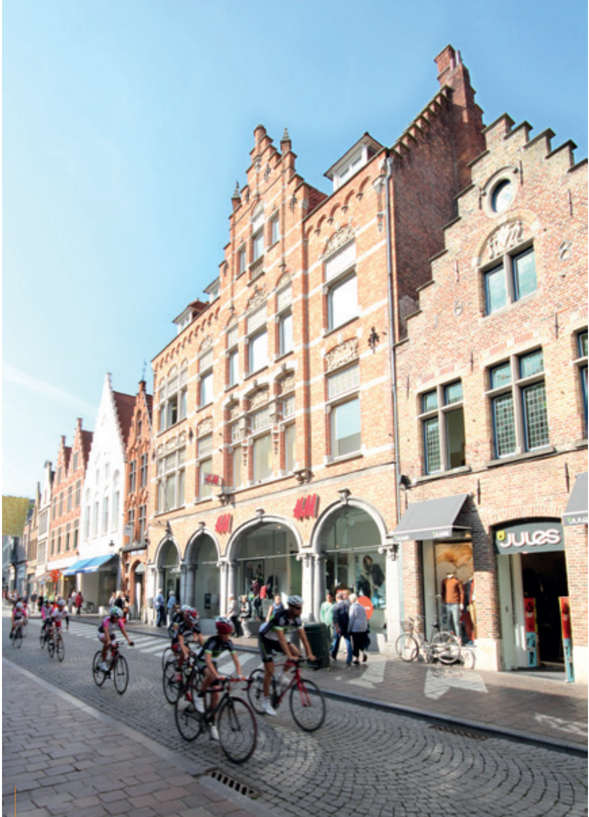
Brugge, Steenstraat - 2.058 m 2
