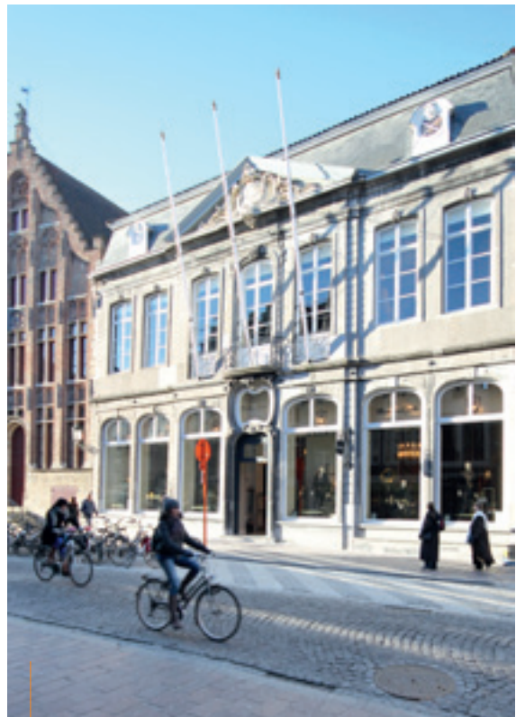
Brugge, Steenstraat - 941 m 2
