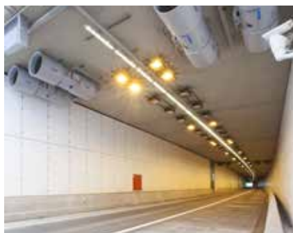
Tunnel R11 - Deurne
