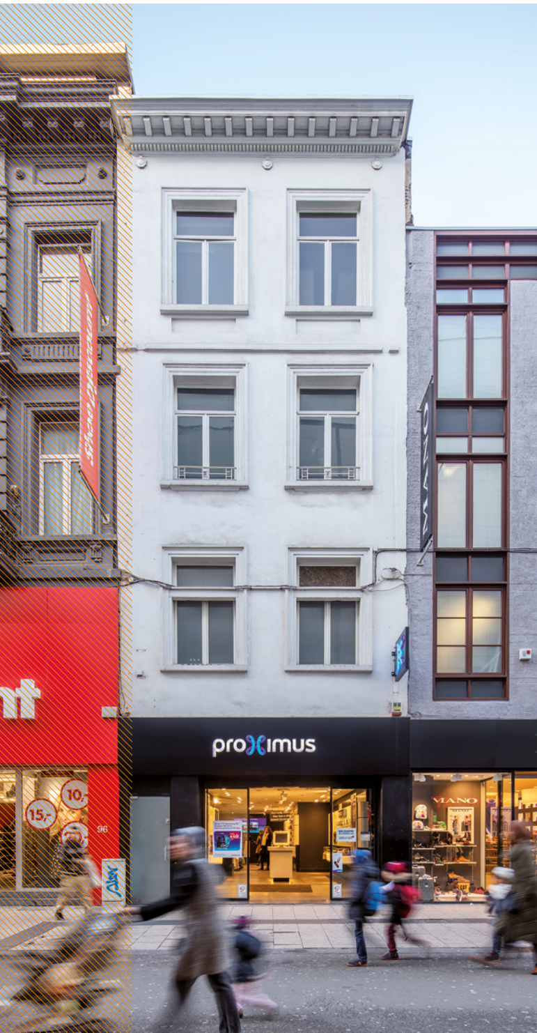
Brussel - Nieuwstraat - Proximus
