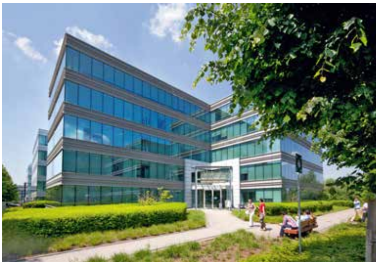
Kantoorgebouw Mediaalaan, Vilvoorde
